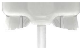
Figura 41: Instalación del tubo en la boca del tanque
